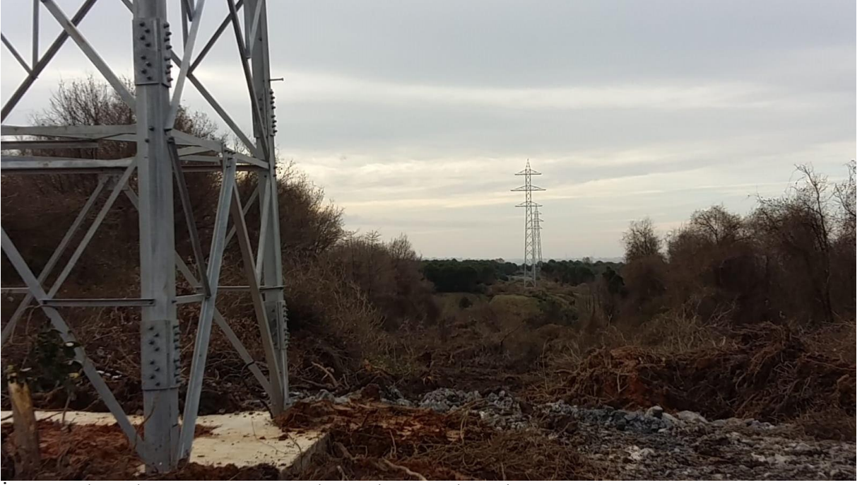
İnşaat Çalışmaları Sonrası D13 Noktasından Görülen Diğer Direkler
