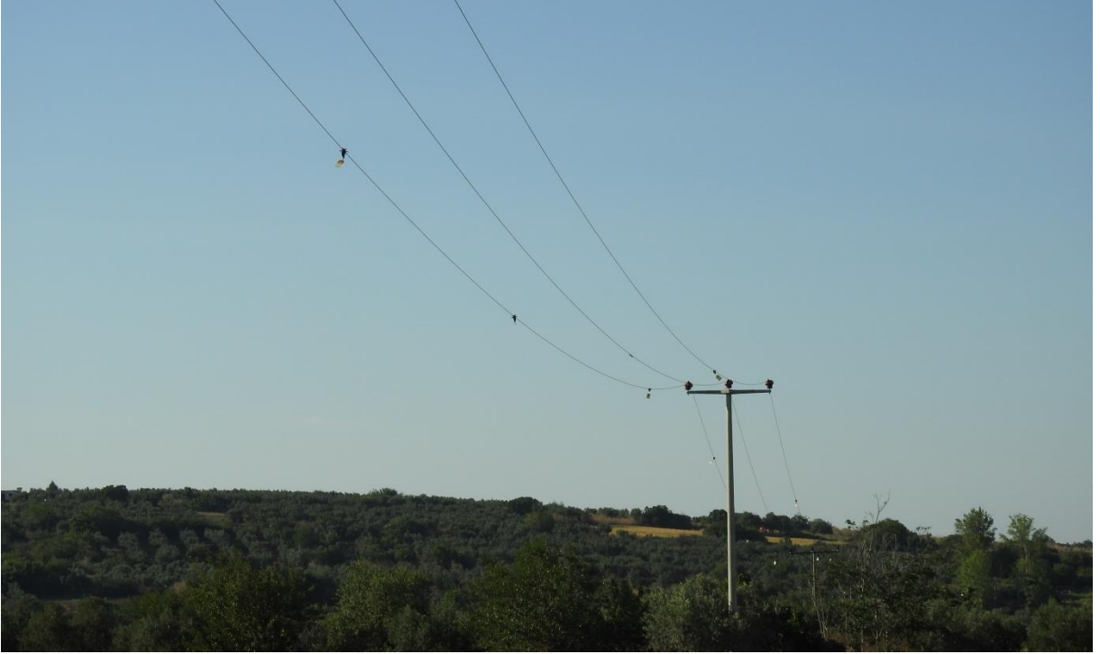
Fotoğraf 2 Eski Karaağaç Avrupa Leylek Köyü'nde Kullanılan UV Uyarıcılar (fire-fly diverter)
